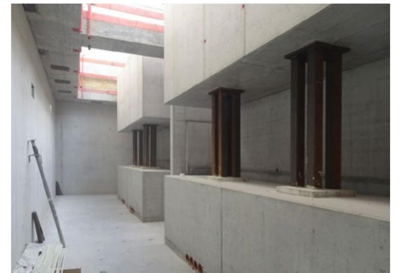
Jede der vier Messkabinen lagert schwingungsentkoppelt auf sechs pneumatisch gesteuerten Federn auf den Fundamentbarren. Die 150 Tonnen schweren Blöcke mussten „schwebend“ auf der endgültigen Höhe betoniert werden.
