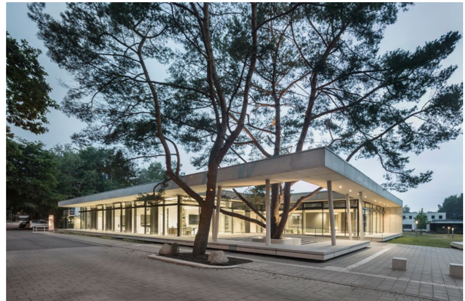
Ein schwebender eingeschossiger Baukörper aus einer markanten, auskragenden Sichtbetonkonstruktion öffnet sich einladend zur Straße und zum Campus-Eingang.
