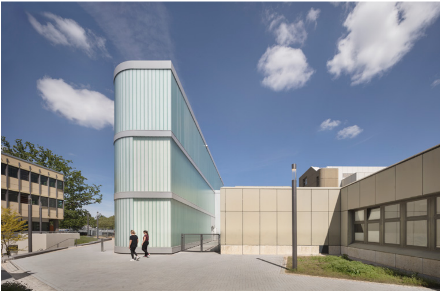
Die beengte Situation vor Ort führt zur besonderen amorphen Form, die an der schmalsten Stelle nur 3 Meter Raumtiefe hat.
