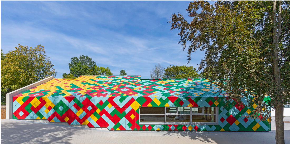
Foto 2: Das Dach ist mit einer Haut aus farblich beschichteten Aluminiumschindeln verkleidet.
