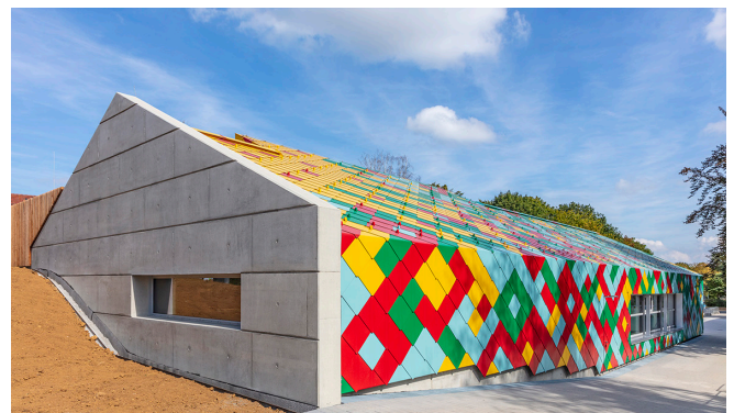
Foto 3: Zur höherliegenden Straße ist der Saal topografisch eingebunden und durch Schichten aus Beton und Holz geschützt.
