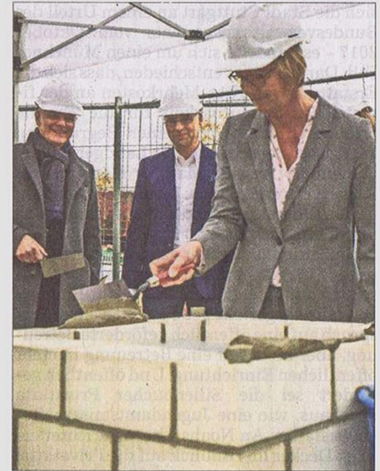
Ministerin Sitzmann mauert, der Architekt und der Institutsleiter (v. li.) sehen zu. Foto: Lg/Rettig
